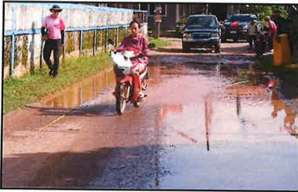
ภาพก่อนดำเนินการ
